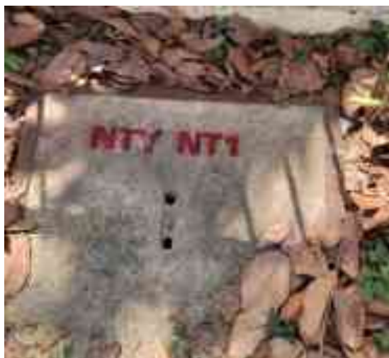
Vị trí hố ga xả nước thải trên đường số 3 công số 1
