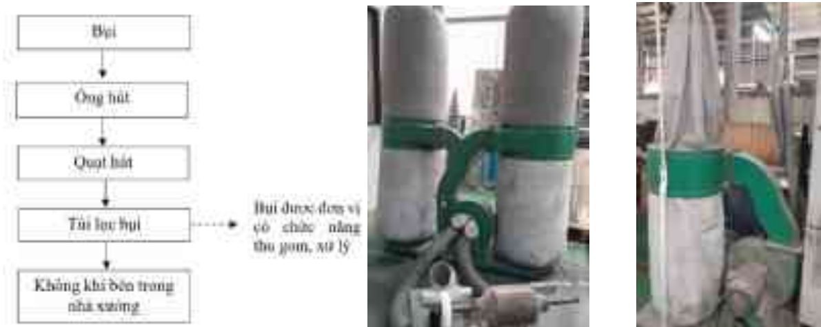
Hình 3. 12. Quy trình thu gom bụi từ công đoạn mài (chà khay), cắt tấm
