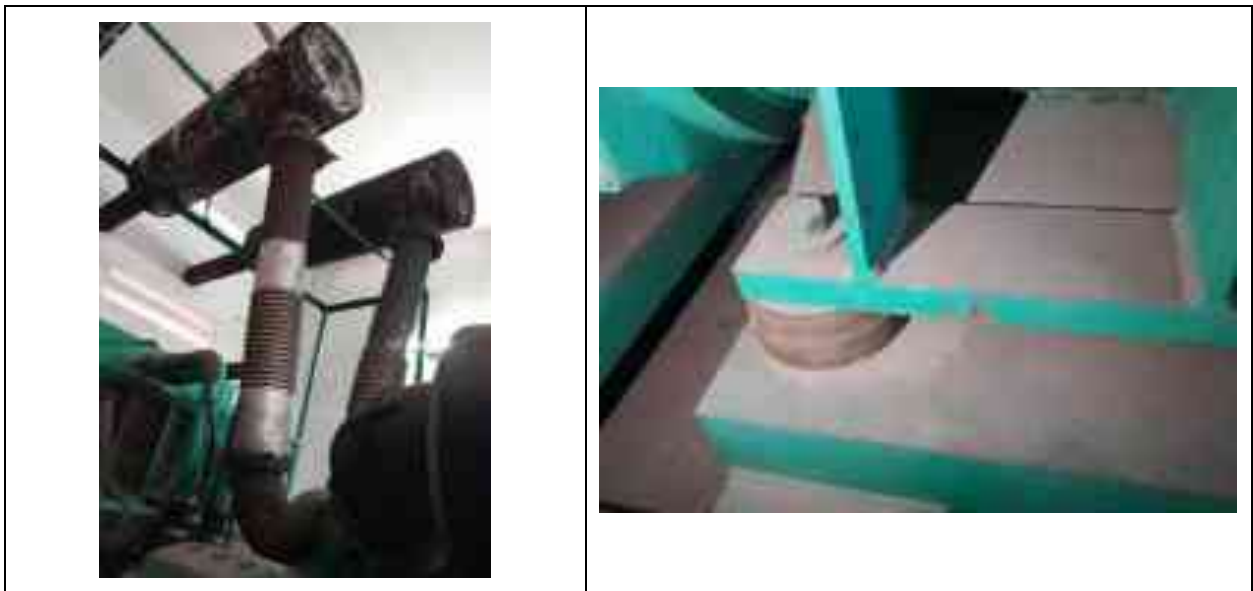
Hình 3. 9. Ống khói máy phát điện dự phòng và bộ phận cao su, giảm thanh
